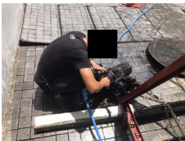
ช่างอาคาร ทำการตรวจเช็คปั้มระบบบำบัดน้ำเสีย
