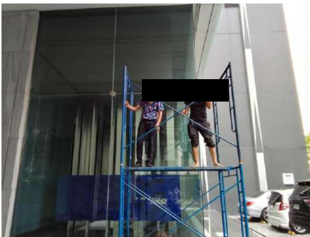
ช่างอาคารติดตั้งฝาครอบไฟ LED แทนที่หลอดชำรุด บริเวณด้านหน้าอาคารพักอาศัย
