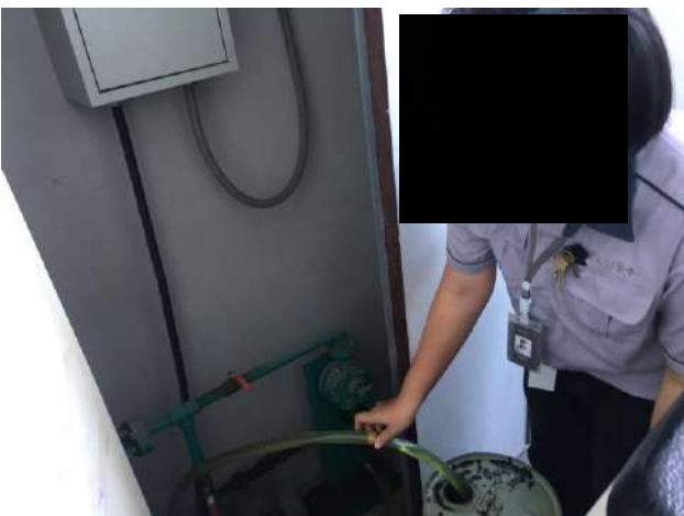
ช่างอาคารเติมน้ำมันเครื่องกำเนิดไฟฟ้าสำรอง (Generator)
