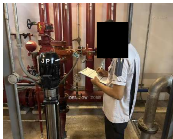
ช่างอาคารตรวจเช็คระบบการทำงาน Generator, Fire pump และ Jokey pump ประจำสัปดาห์
