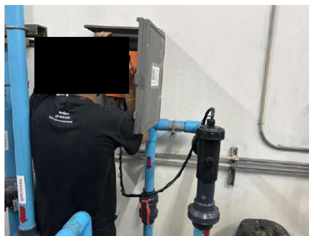
ช่างอาคารทำการติดตั้งเครื่องผลิตคลอรีน สระว่ายน้ำใหม่
