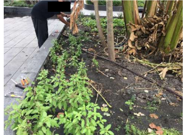
ช่างอาคารใส่ท่อสายไฟ HDPE ลานจอด ชั้น 10 และ แนวรอบกำแพงโครงการฯ
