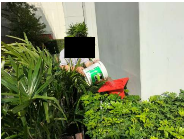
ช่างอาคาร ทำการเติมจุลินทรีย์บ่อบำบัด อาคาร A และ B
