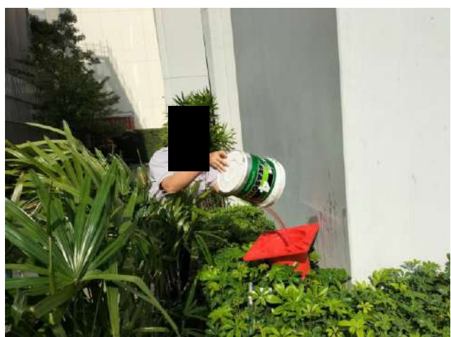
ช่างอาคาร ทำการเติมจุลินทรีย์บ่อบำบัด อาคาร A และ B
