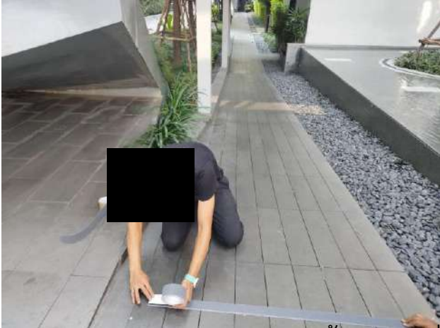
ช่างอาคาร ติดตั้งแผ่นกันลื่น บริเวณทางเดินไปที่จอดรถ
