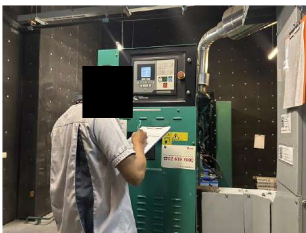
ช่างอาคารตรวจเช็คระบบการทำงาน Generator, Fire pump และ Jokey pump ประจำสัปดาห์
