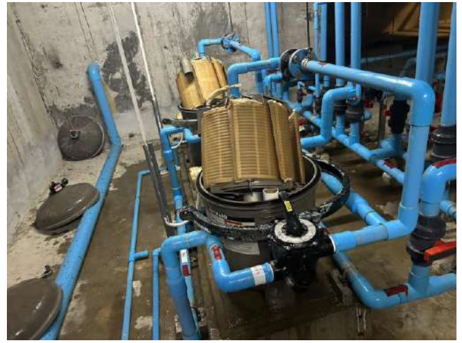
ช่างอาคาร ทำการล้างกรองสละว่ายน้ำ,กรองบ่อพอน1-3
