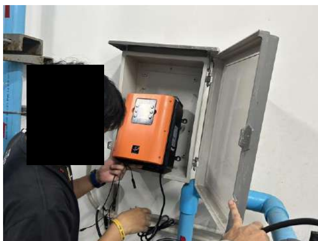
ช่างอาคารทำการติดตั้งเครื่องผลิตคลอรีน สระว่ายน้ำใหม่
