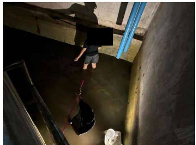
ช่างอาคารล้างทำความสะอาดถัง Surge tank สระว่ายน้ำ พร้อมเติมน้ำยาฆ่าเชื้อ
