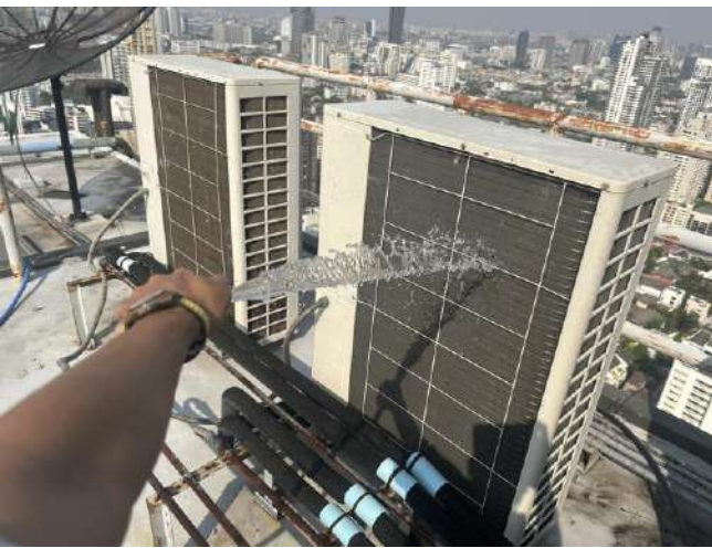
ช่างอาคาร ทำการล้างคอยล์ร้อนแอร์ห้องลิฟต์
