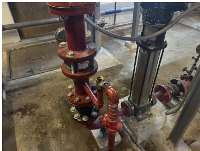
ช่างอาคาร ทำการติดตั้งปรับตั้งรีลีฟวาล์วค้ำง ระบบดับเพลิง
