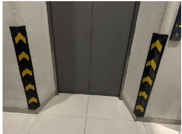
ช่างอาคาร ติดยางกันกระแทกหน้าลิฟต์ชั้นของ
