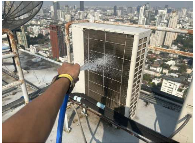
ช่างอาคาร ทำการล้างคอยล์ร้อนแอร์ห้องลิฟต์
