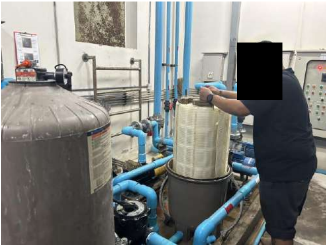
ช่างอาคาร ทำการล้างกรองสละว่ายน้ำ,กรองบ่อพอน1-3
