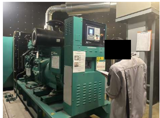
ช่างอาคารตรวจเช็คระบบการทำงาน Generator, Fire pump และ Jokey pump ประจำสัปดาห์
